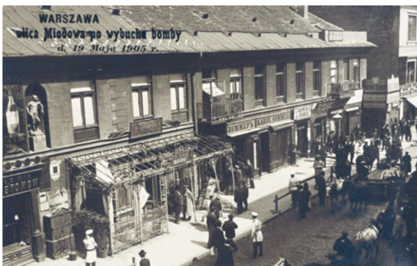
10. Zniszczenia na ul. Miodowej w Warszawie po wybuchu bomby, rzuconej przez jednego z bojowców PPS w 1905 r.
