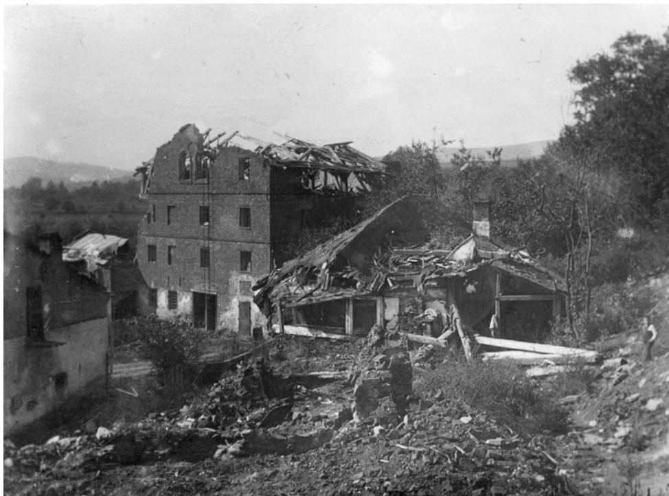
2. Zniszczone domy mieszkalne w Gorlicach, autor zdjęcia nieznany, Narodowe Archiwum Cyfrowe
